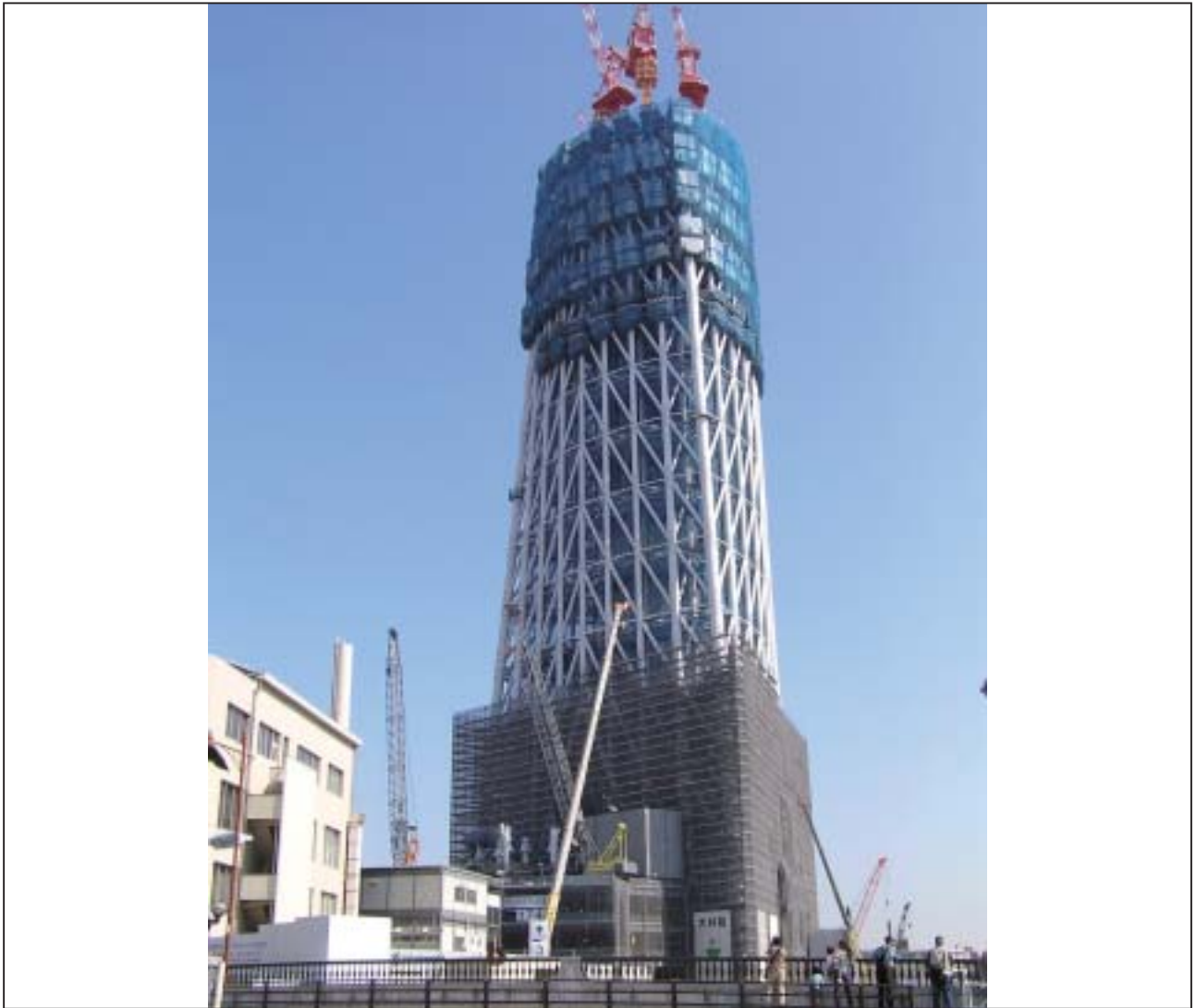
新シリーズ 東京スカイツリー建設進捗状況を区内各所から 東武橋より新タワーを望む
