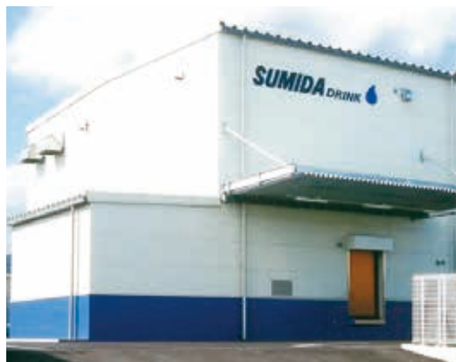
2009年に茨城県土浦市に設立したつくば工場
